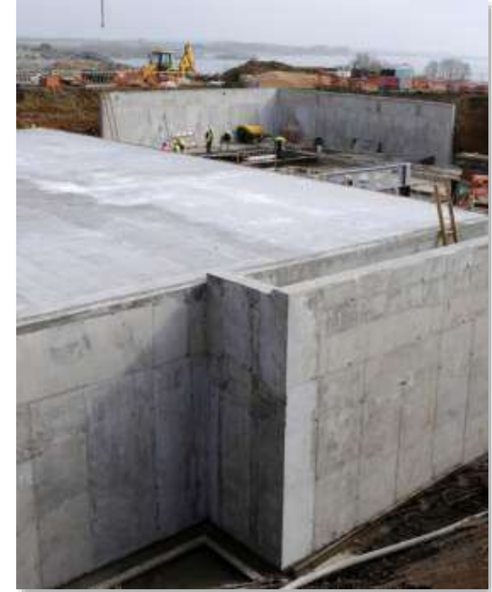
VANNTETTING AV KJELLERE
