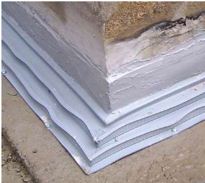
Tricoflex profil DFT 330 KI Montering
