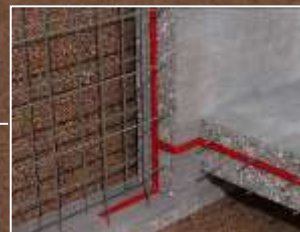
Støpeskjøter Svellebånd og svellemasse
