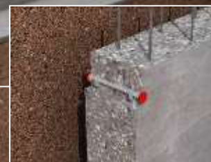
Tetting av formstaghull
