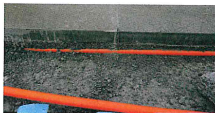
Varmerørene legges direkte i settemassen.
