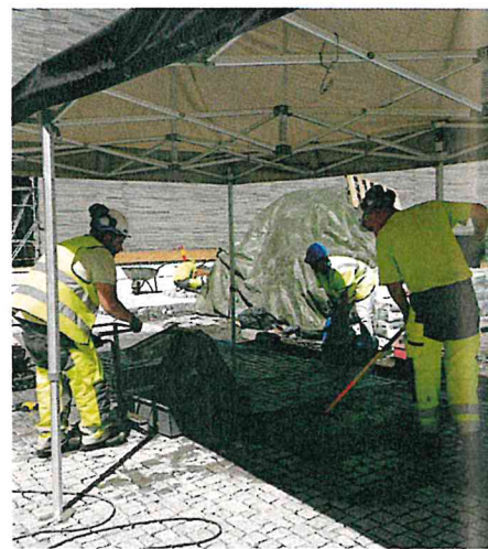
Fugeprosessen er effektiv og kan gjøres stående.
