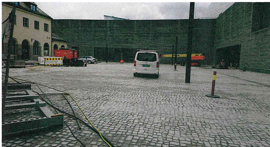
Nye Nasjonalmuseet åpner dørene i 2021 – på uteområdet er det lagt smågatestein. For å legge smågatesteinen er det her brukt BETO naturSETTE-D som er vanngjennomtrengelig og hindrer vannoppsamling under steindekket.
