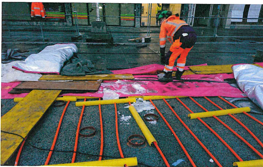
På Torvet i Trondheim er det lagt vannbåren varme under skiferheller.
