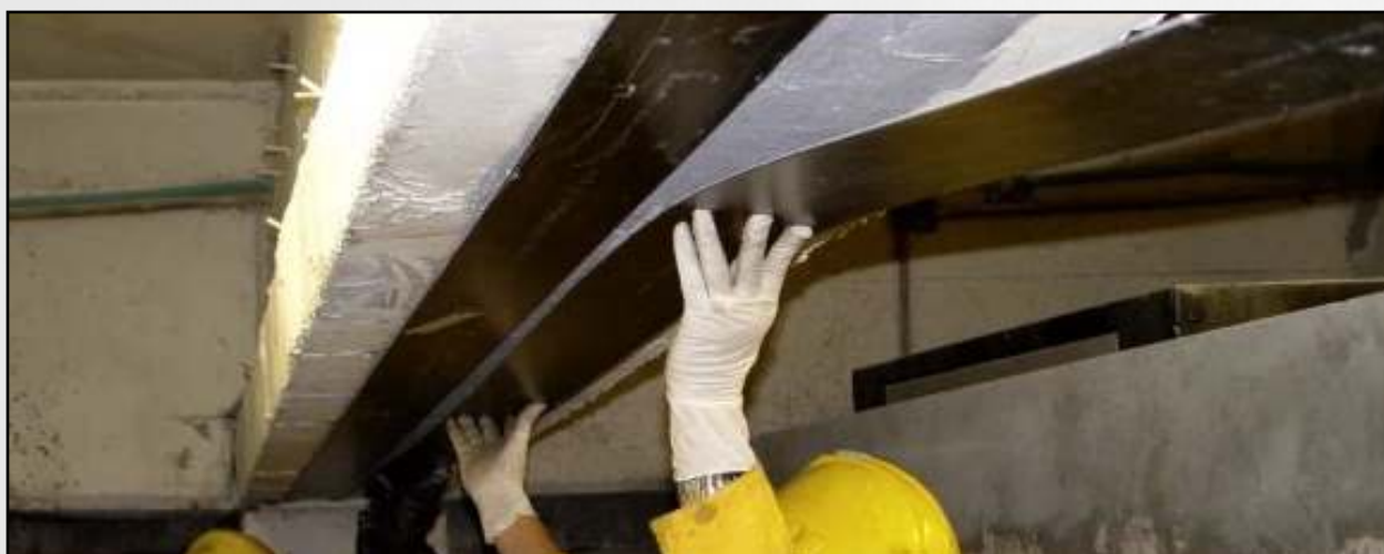
Montering av Carbodur · Limes fast med tilhørende lim på eksisterende konstruksjon
