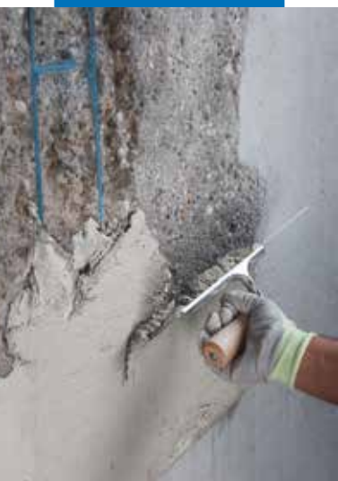
Påføring av Planitop Smooth & Repair med sparkel
