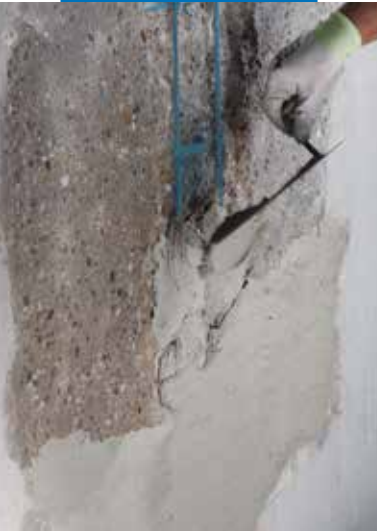
Påføring av Planitop Smooth & Repair med murskje
