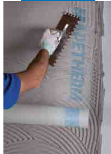
Armering med Mapetherm Net innbakt i fersk Mapetherm AR1 GG
