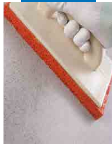
Sluttfinish av puss utført med brett og svamp
