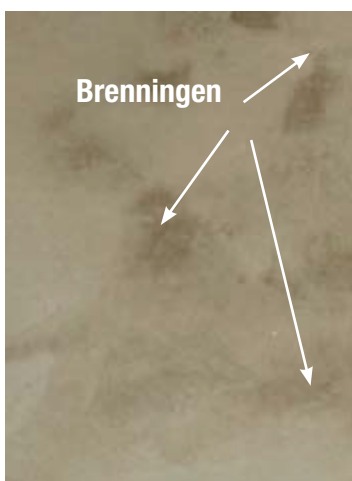
Med disse to verktøyene «brennes» betongen som vist til venstre (marmorering). Man kan også få en mer ensartet overflate som på bildet til høyre.
