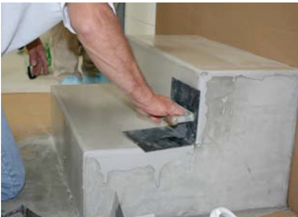
Gjør det samme på inntrinnet med et pussebrett for innvendig vinkel.
