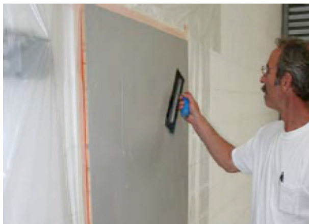
Glatt ut. Lakker trappene og veggen. Det er ikke nødvendig å vokse veggene.
