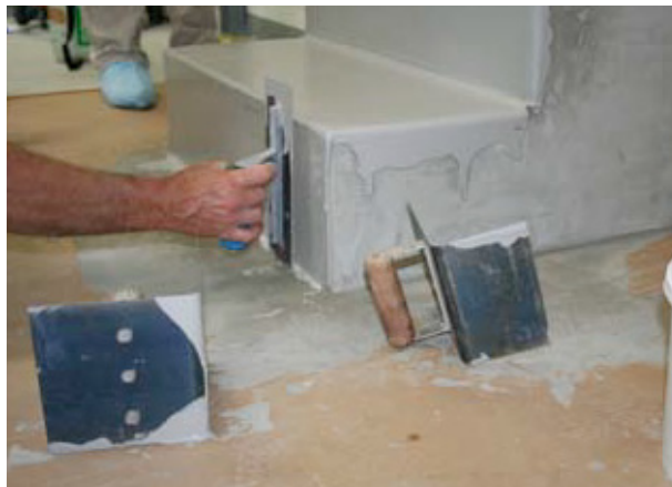
Glatt ut dråper på de loddrette partiene før de tørker. Det vil bli en linje ved trappenesen og inntrinnet; denne vil forsvinne ved pussing med korn 120 når den er tørr.
