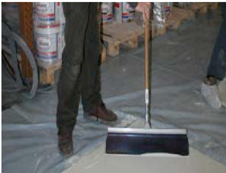
I likhet med finish-pulveret kan NivO'grip påføres med en gulvskrape med skaft...
