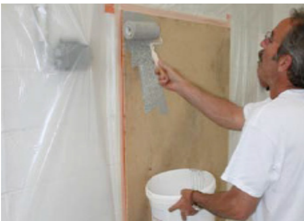
På vegg påføres Béton Ciré med rulle (for sparkling) eller med et murebrett (A) og et pussebrett.
