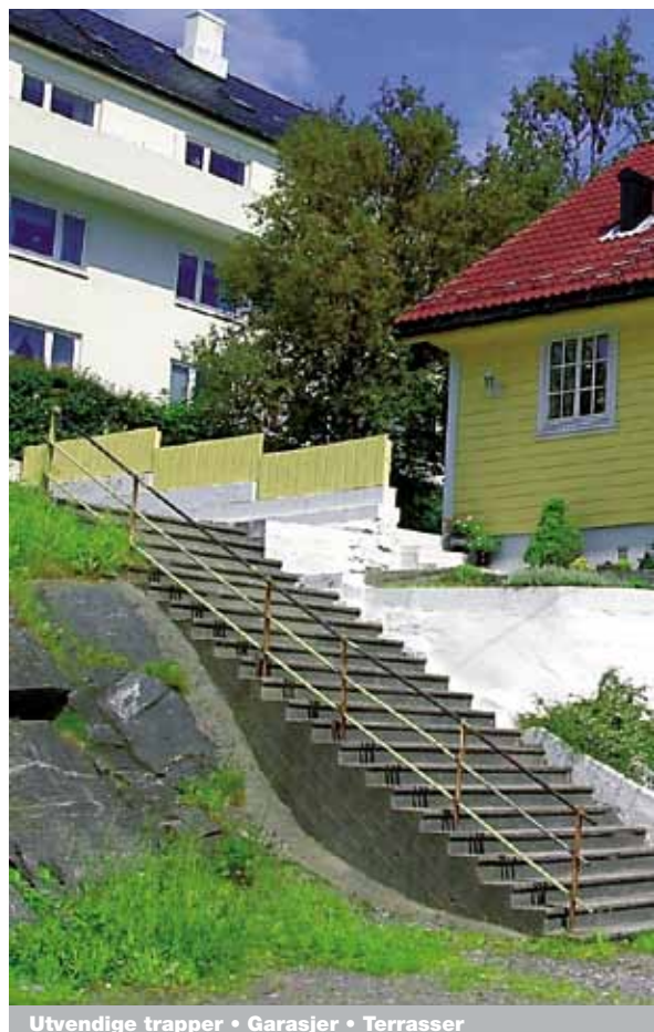
Utvendige trapper • Garasjer • Terrasser
