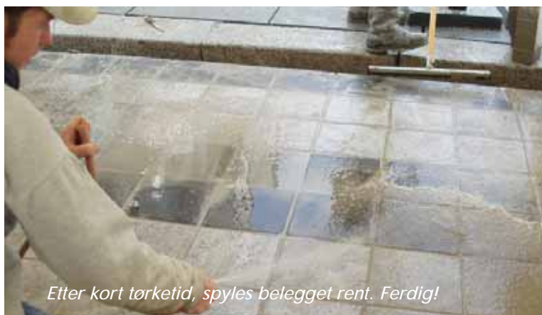
Umiddelbart etter at stein er satt, svabres fugemassen ut
