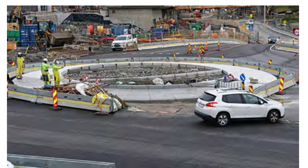
Bærelag av drensbetong, settelag med BETO naturSETTE-D, fuget med BETO naturFUG
