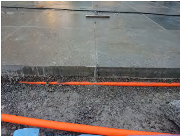
Bærelag av drensbetong, settelag med BETO naturSETTE-D, fuget med BETO naturFUG
