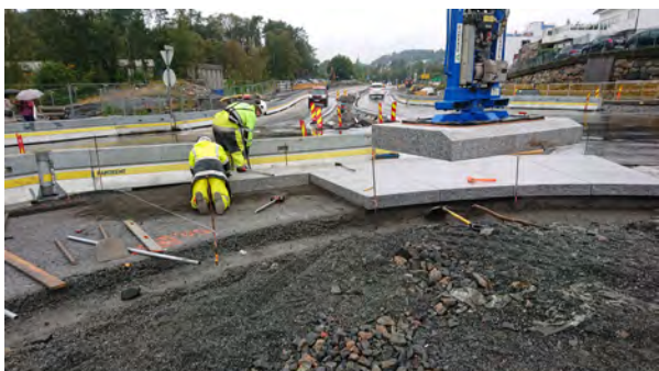
Bærelag av drensbetong, settelag med BETO naturSETTE-D, fuget med BETO naturFUG
