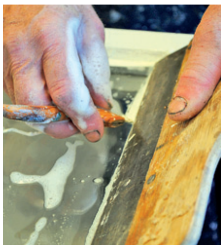
Kantskär kittfalsarna i svagt såpvatten.
