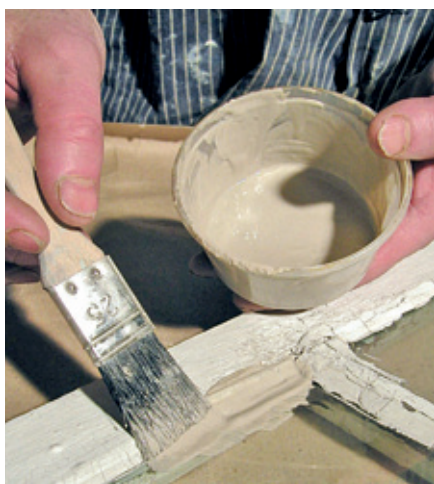
Kittvälling, enkel "fördröja åldrandet" åtgärd.
