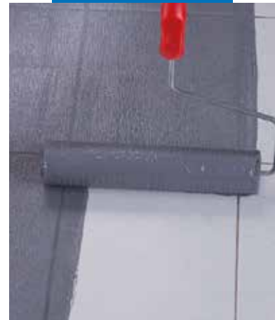
Påføring av Eco Prim Grip Plus med rulle på eksisterende porselensfliser
