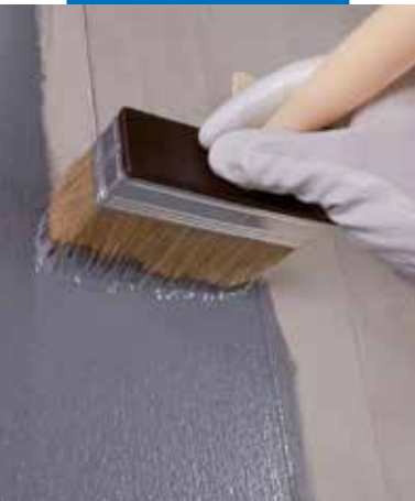
Påføring av Eco Prim Grip Plus på betong med børste
