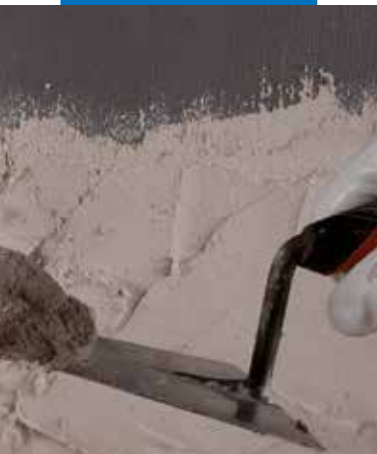
Påføring av puss over Eco Prim Grip Plus
