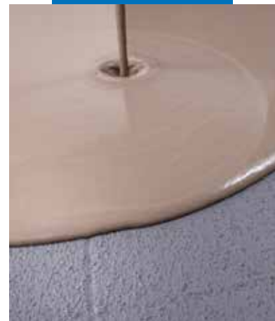
Påføring av Uniplan Eco selvutjevne avrettingsmasse over tørr Eco Prim Grip Plus på gammel gulv
