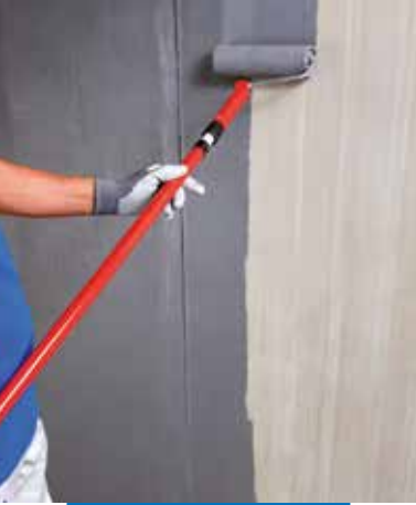
Påføring av Eco Prim Grip Plus på betong med rulle
