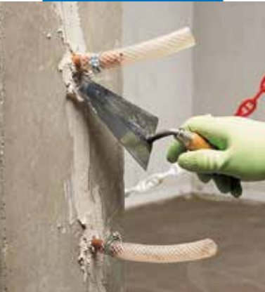
Innfesting av rør til injisering, og tetting av strukturelle sprekker
