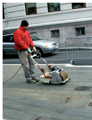
Berta "børster" opp det meste av den overskytende fugemassen. Raskt og effektivt.
