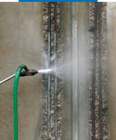
Rengjøring av armering
