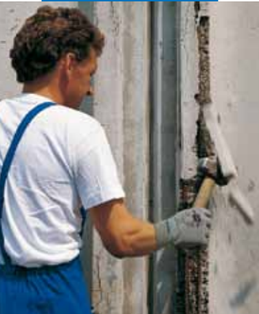
Fjerning av nedbrutt betong
