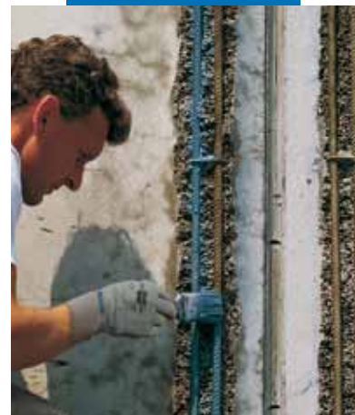
Påføring av Mapefer
